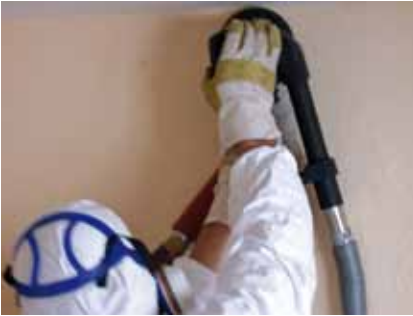
Schimmelpilzsanierung mit Putzfräse
